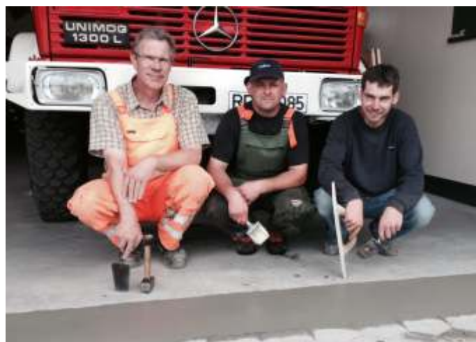
Selbsthilfe der Kameraden bei Umbaumaßnahmen
